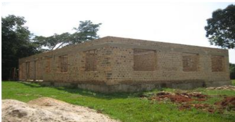
Construction of OPDat Katoogo HCIII
