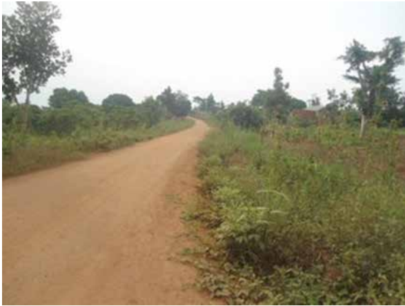
A section of Kikuuta-Gayaza-Mbulire road at 1+600
