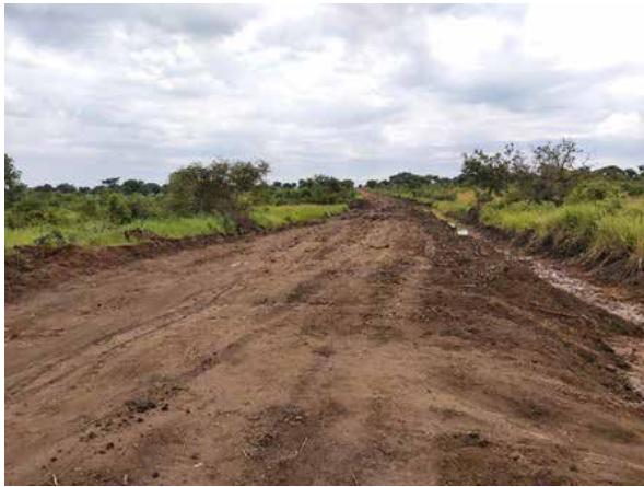
Embankment fill on Pader-Latanya-Dure Road
